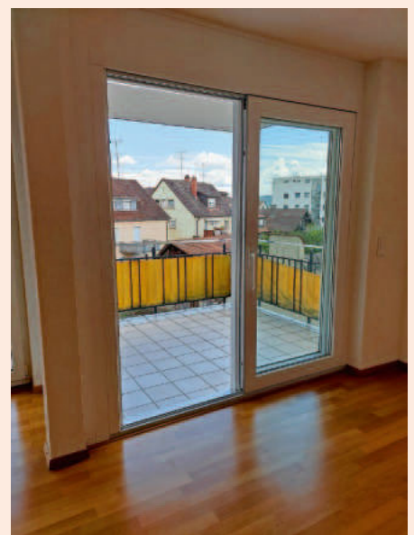
Türschwellen, wie sie an Übergängen zu Balkonen häufig zu finden sind, können zu schwer überwindbaren Hindernissen werden.
