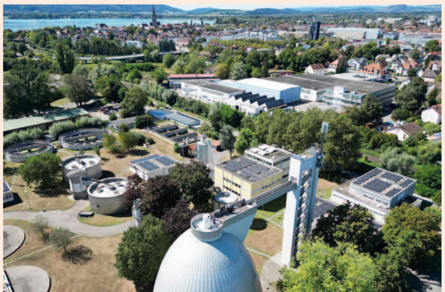
Luftbild der Kläranlage. Sechs Dächer der Kläranlage sind nun mit PV-Modulen belegt. Bild: Solare Technik Klinkenberg
